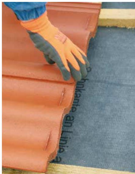
▲ Die Dachdeckung erfolgte mit der Harzer Pfanne F+, die über eine integrierte Regensperre verfügt
