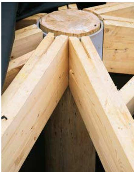
▲ Die Dachlasten werden über einen Rundstamm abgetragen, der das Zentrum im Gebäudeinneren markiert
